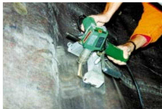
TWINNY S com cunha curta combinada num túnel.
