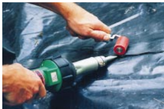
Soldagem por sobreposição de uma geomembrana PE-HD com TRIAC PID.
