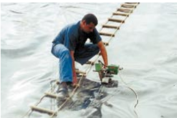
TWINNY T a soldar tela de PE-HD, de 1.5 mm com canal de ensaio, num aterro.
