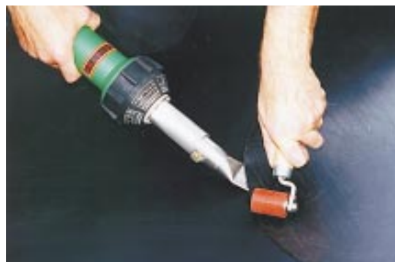
TRIAC S com terminal de fenda larga e rolo de pressão soldando alguns pontos antes da soldagem definitiva.
